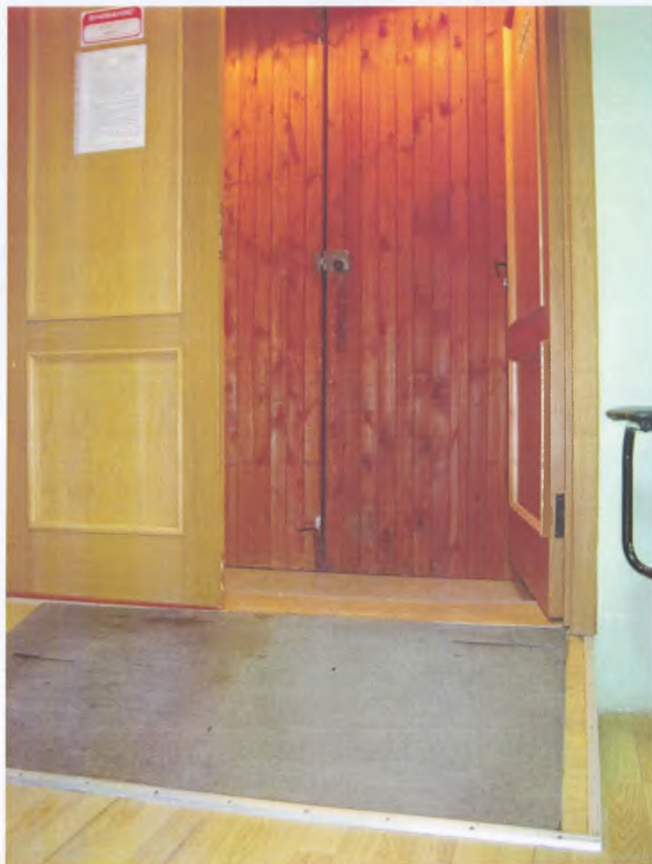
Эвакуационный выход через актовый зал
