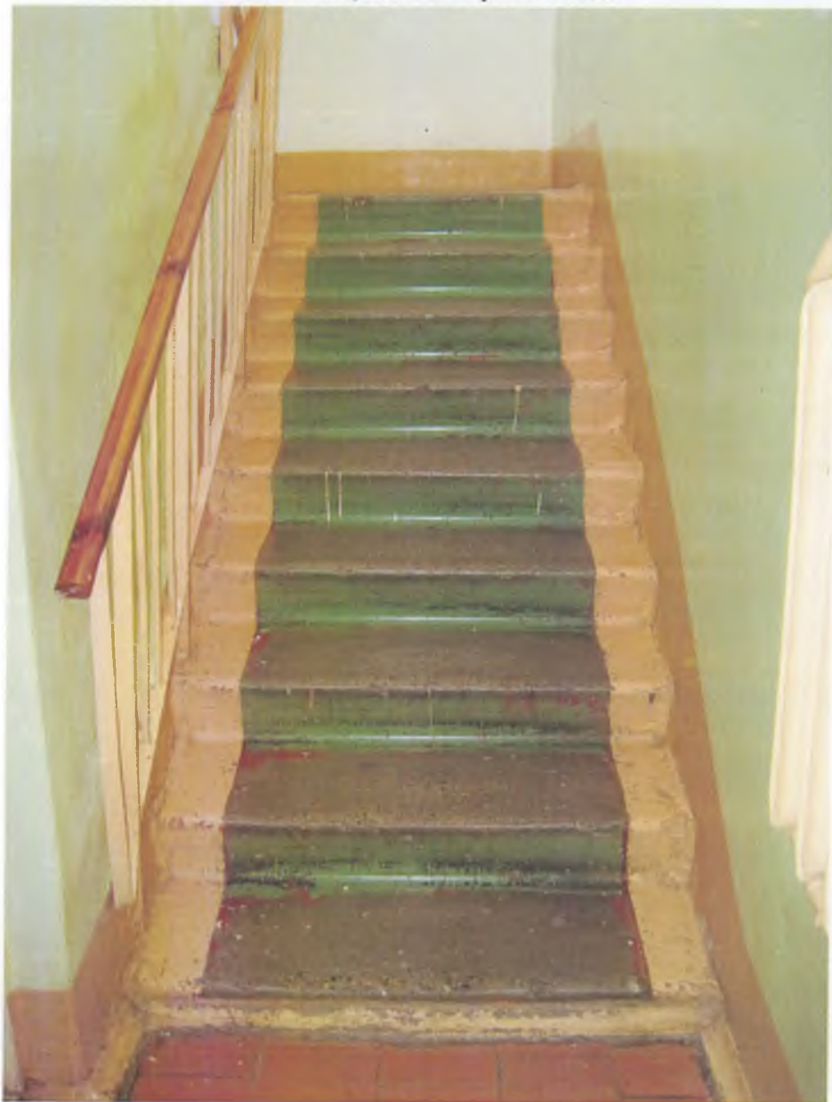
Лестница на второй этаж
