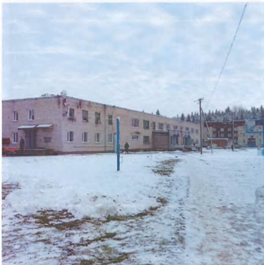
Внешний вид здания
