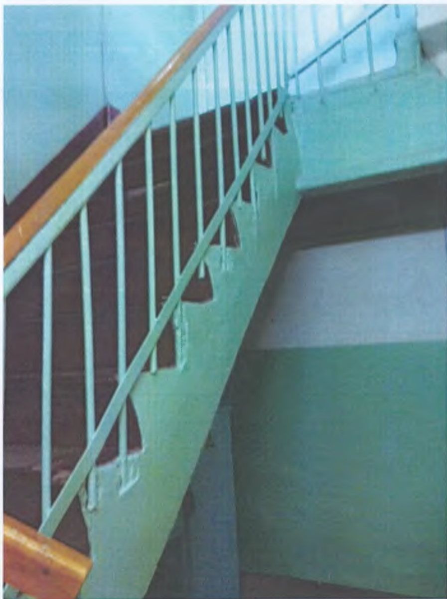
Лестница на второй этаж
